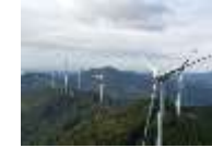
浜松風力発電所
