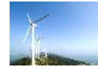
佐多岬風力発電所
