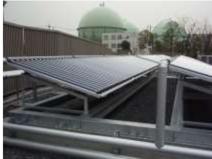
東京ガス千住テクノステーション
