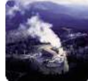
澄川地熱発電所
