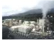
八丈島地熱発電所
